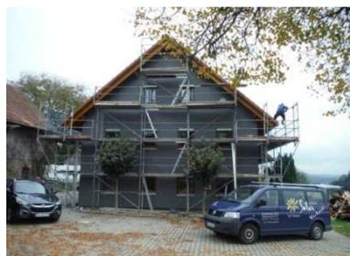
Nachdem der Dachstuhl aufgerichtet war und mit neuen Dachziegeln eingedeckt wurde, entfernte man sämtliche alten Fenster die man dann durch 3-fach verglaste Elemente ersetzte.
